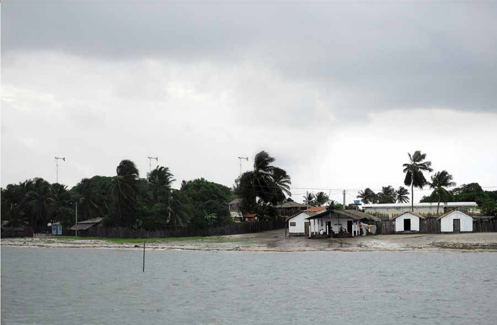
As torres de captação de energia eólica (ao fundo) e as placas solares instaladas na laje do centro de operação garantem, durante 24 horas, a energização de 89 casas da Ilha.
