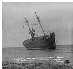
Gerador eólico no navio "Chance" - 1902 - Nova Zelândia
