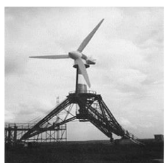
Turbina eólica experimental em Nogent-le-Roi, França - operou entre 1958/62 (800 kW).
